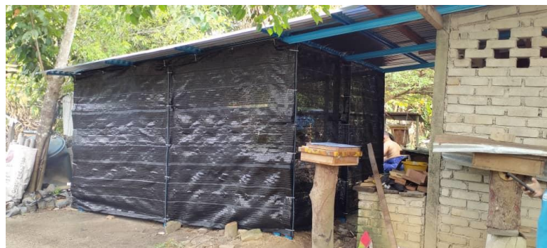
4. Membina dengan battern besi
